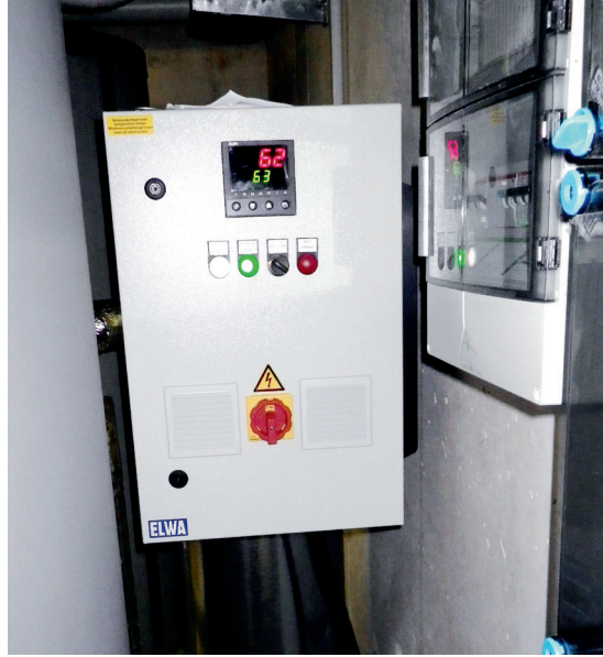
Das P2H compact Modul von Elwa deckt den kleineren Leistungsbereich ab. Im Bild eine Anwendung zur Legionellenprävention.
