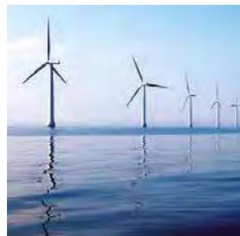
Offshore-Windkraftanlagen: Zuverlässigkeit und lange Standzeiten der Ölversorgung gewährleisten einen wirtschaftlichen Betrieb
